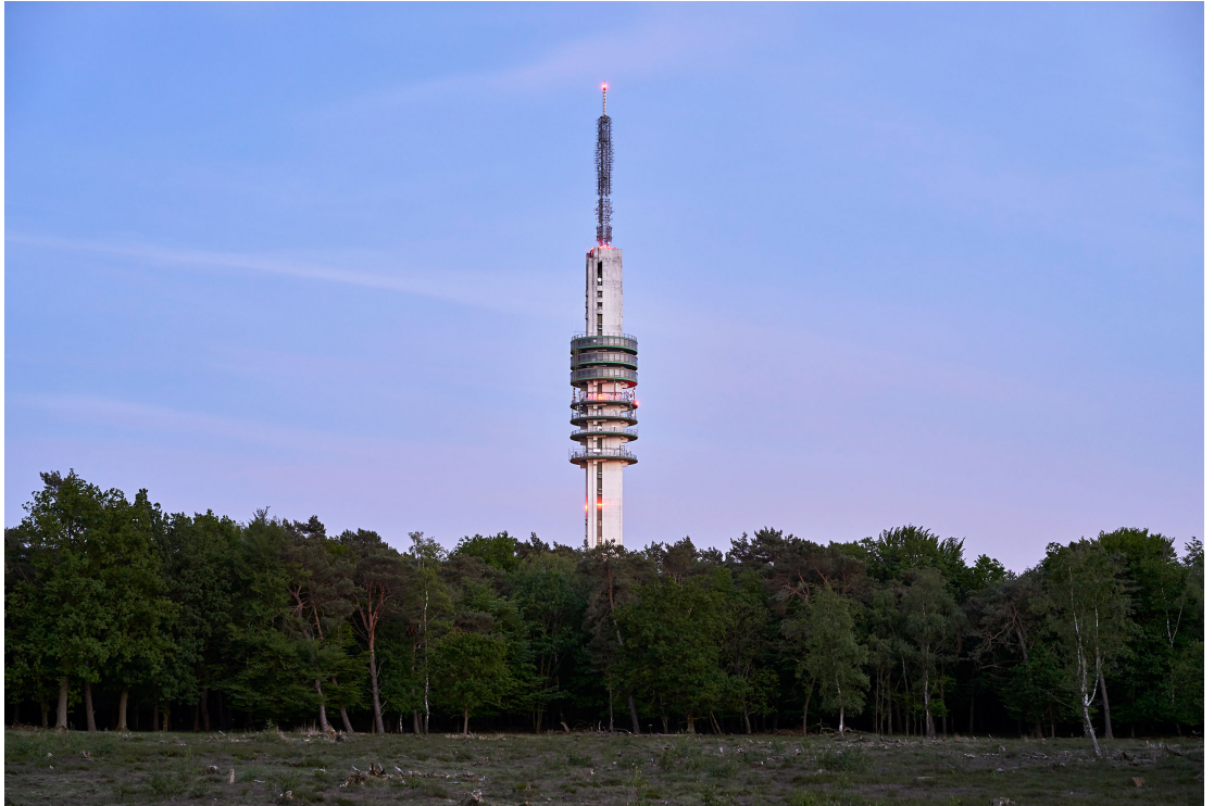
Alticom Datacenter, Hilversum.
